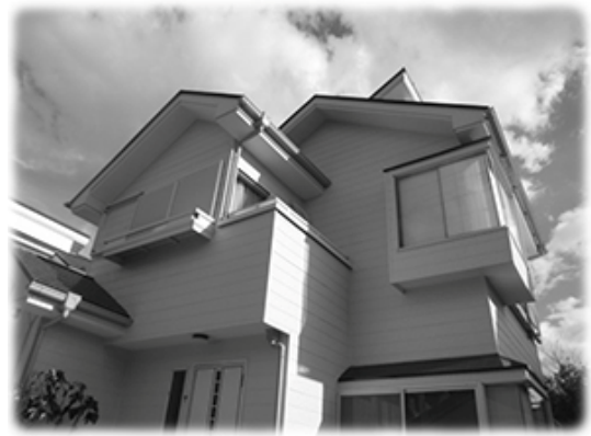
全ての施工が完了し、足場を解体したあとの外観
