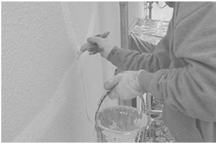
クラックの部分にファイラーを1層多く塗り終わった後に下塗りの中塗り、最後の上塗りを進めていきます。狭い部分はローラーで無理やりに塗装すると塗料溜まりが出来てしまったり、掠れが出たり、はみ出してしまったりと仕上がりが悪くなってしまいうので、先に刷毛を使って塗装しておきます。これを専門用語でダメ込みと言い、塗装では良く使われる手法の1つです。足場が組めないベランダの上の外壁部分などは脚立を使って作業しました。こちらのお宅は外壁と隣との境界が狭いので、体を付けて塗料を擦ってしまわないように気を付けてながら作業。最後にはあれほど多く見えていたクラックの跡も分からない、綺麗な仕上がりました。
