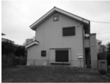
塗装前の外観、右端の凸部がバルコニー
